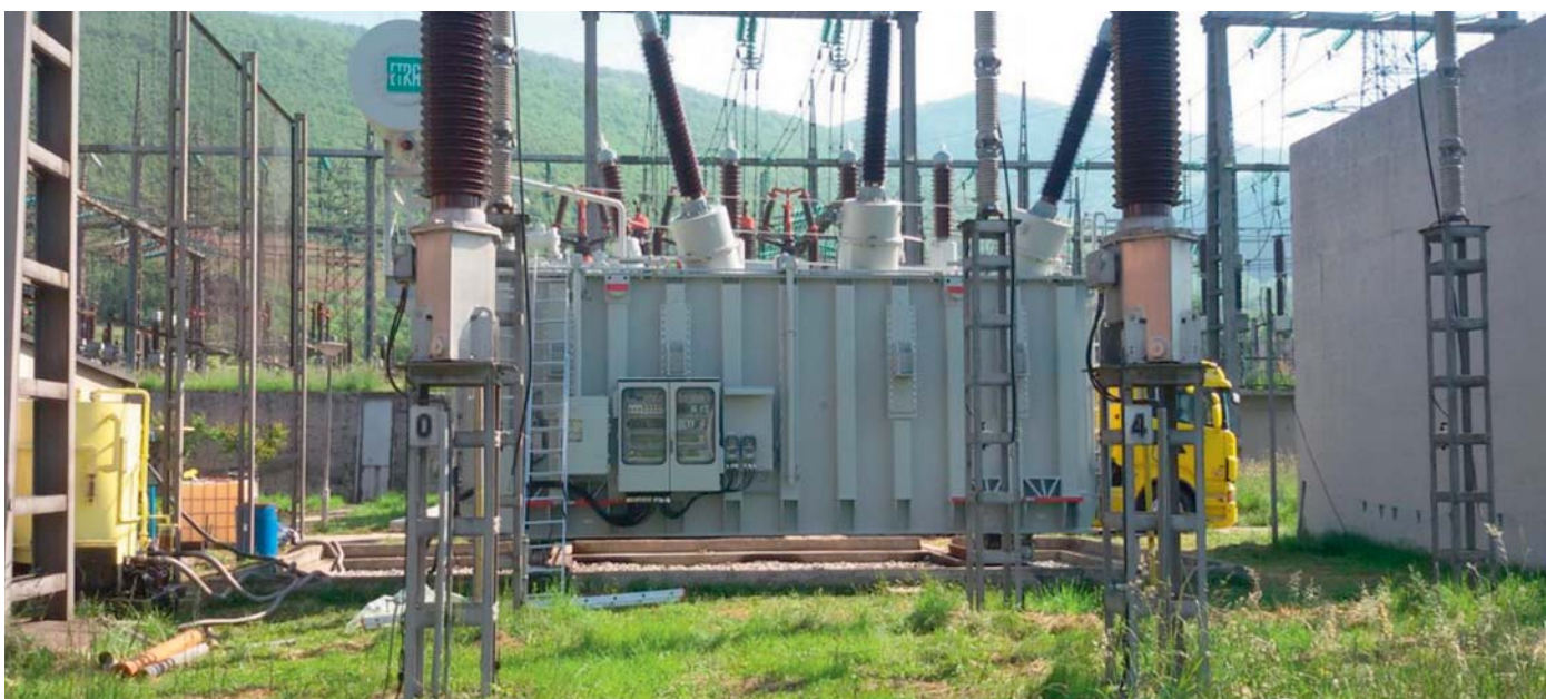
Transformator u svom polju
