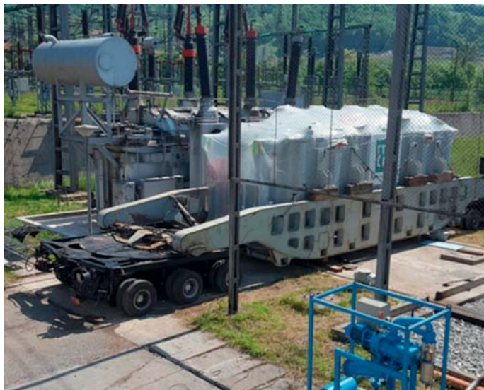
Transformator na specijalnom vozilu za teške drumske transporte
