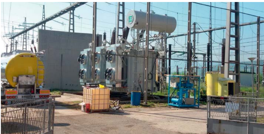
Punjenje auto-transformatora izolacionim uljem
