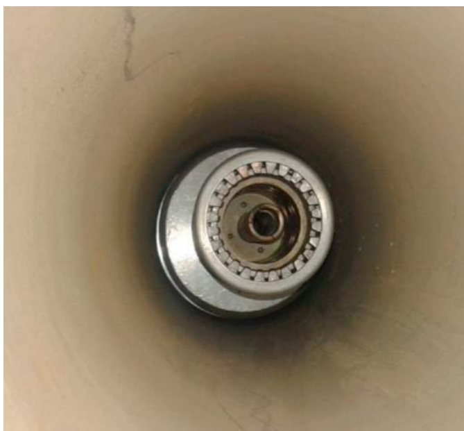
Nepokretni kontakt nakon sanacije
