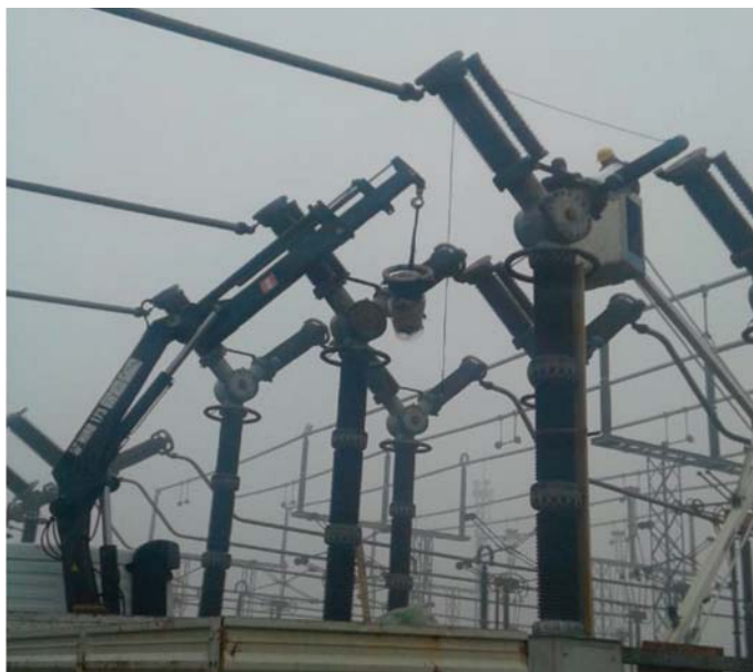
Demontaža havariisanog prekidnog elementa
