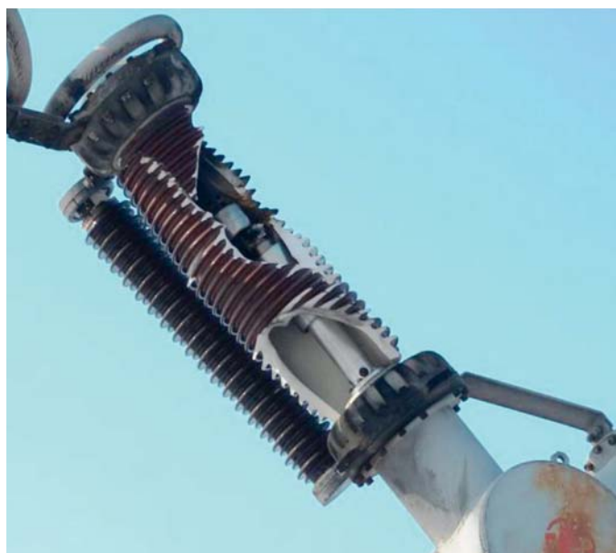
Prikaz havarisanog prekidnog elementa
