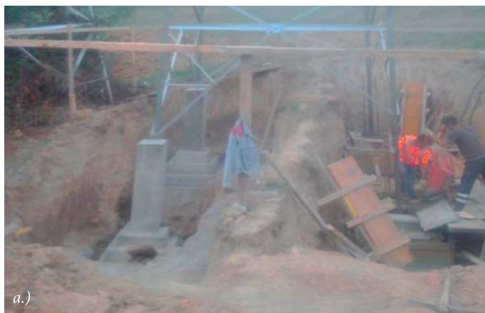
Slika 8. Temeljenje SM 4 na DV 110 kV Ugljevik–Zvornik: a.) temeljenje na kontraforima, b.) završeni radovi
