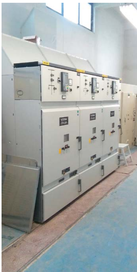
Slika 2. Izgled novougrađenih ćelija 35 kV
