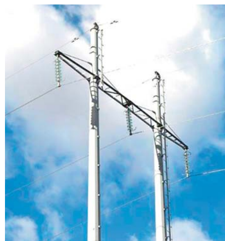
Novi nosivi cijevni poligonalni stup – DCNc1, oblika glave „portal“
