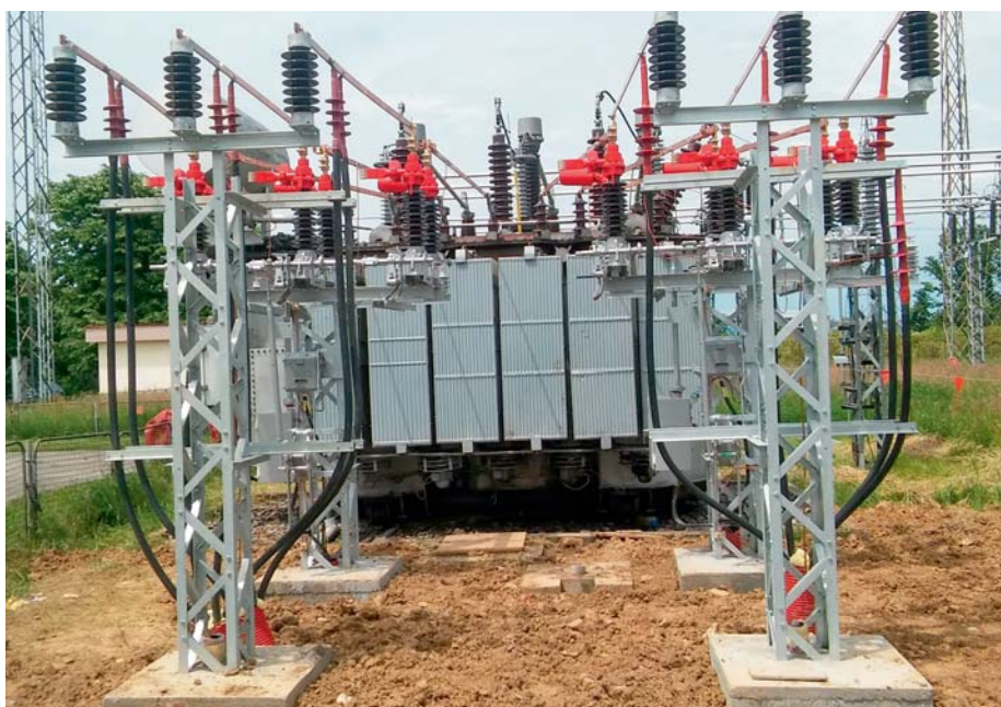
Slika 3. Izgled vanjskog postrojenja TR 3 35 kV i 10 kV nakon rekonstrukcije i proširenja TS
