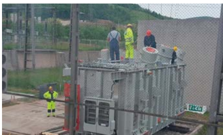
Pripreme za početak montaže transformatora unutar transformatora, te koncentraciju vlage unutar transformatora.
