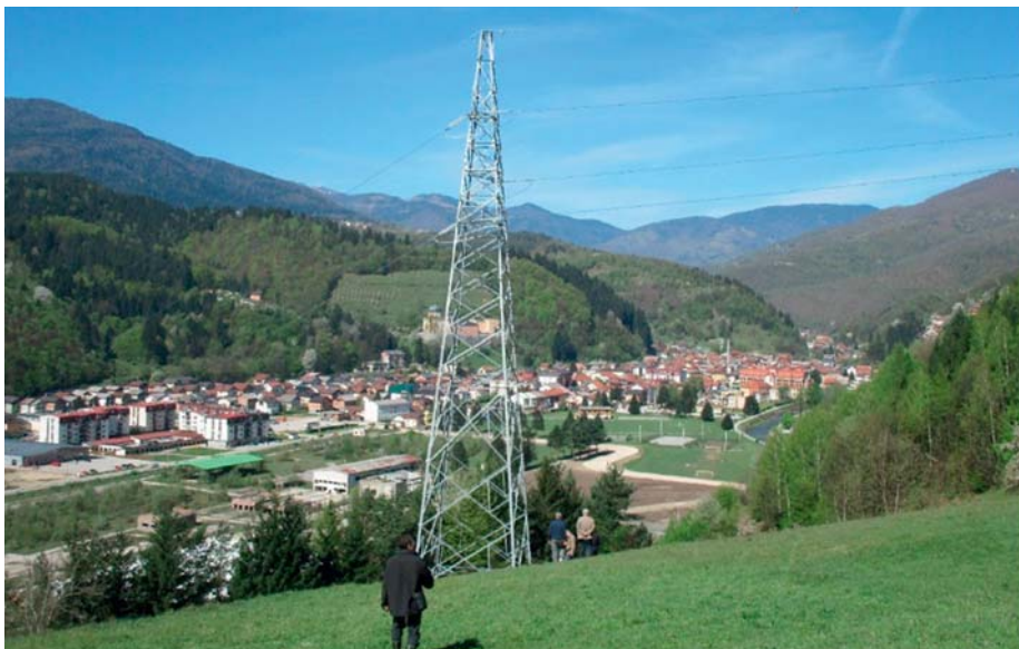
Dalekovod 110 kV TS Visoko – TS Fojnica, po kojem će opština Fojnica biti direktno povezana sa prenosnim sistemom
