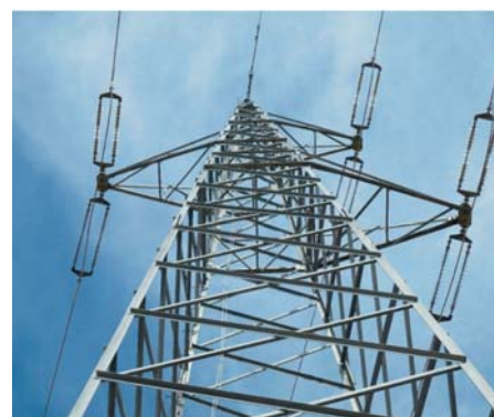
Dalekovod 110 kV TS Visoko – TS Fojnica
