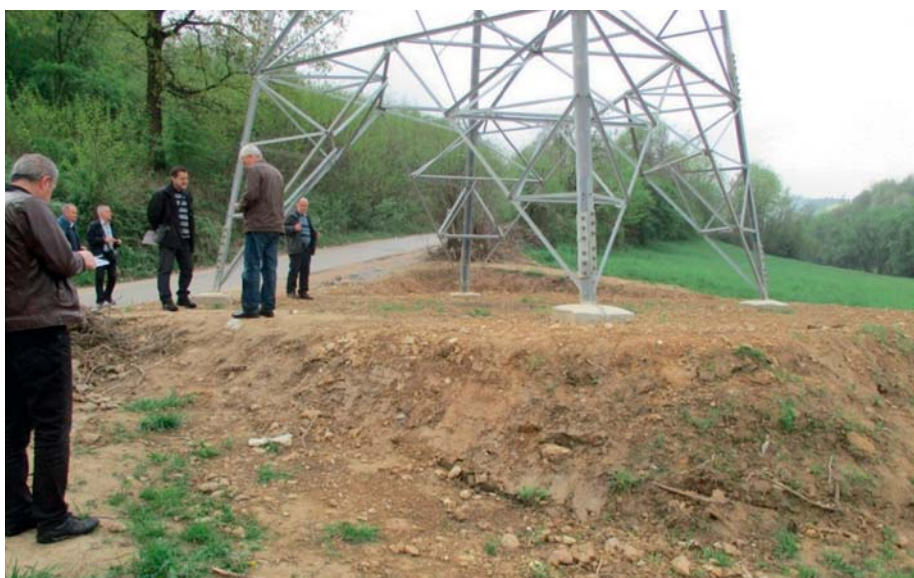
Dalekovod 110 kV TS Visoko – TS Fojnica – komisija Operativnog područja Sarajevo na internom tehničkom pregledu izvedenih radova
