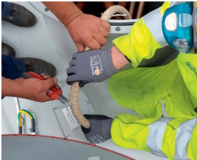
Priprema za montažu provodnih izolatora
