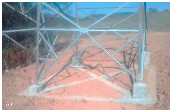
Slika 8. Temeljenje SM 4 na DV 110 kV Ugljevik–Zvornik: a.) temeljenje na kontraforima, b.) završeni radovi
