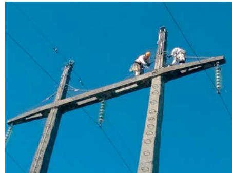
Radovi u tijeku – rekonstrukcija tijela armiranobetonskih stupova
